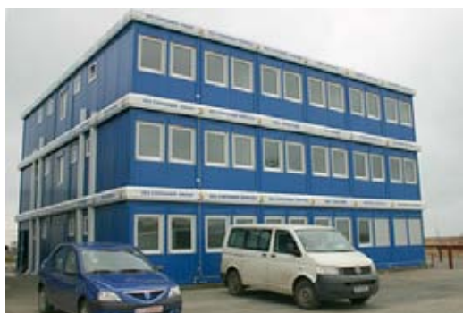
Центральный диспетчерский пункт управления объектами ЖКХ
